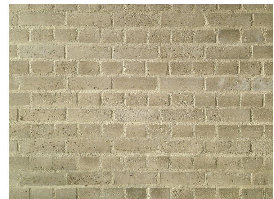
Wand aus Lehmziegelsteinen.
