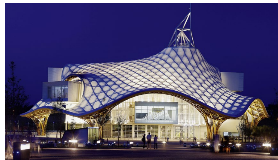
Von diversen Ingenieuren entworfen: die Konstruktion des Centre Pompidou-Metz, 2010 eröffnet.
