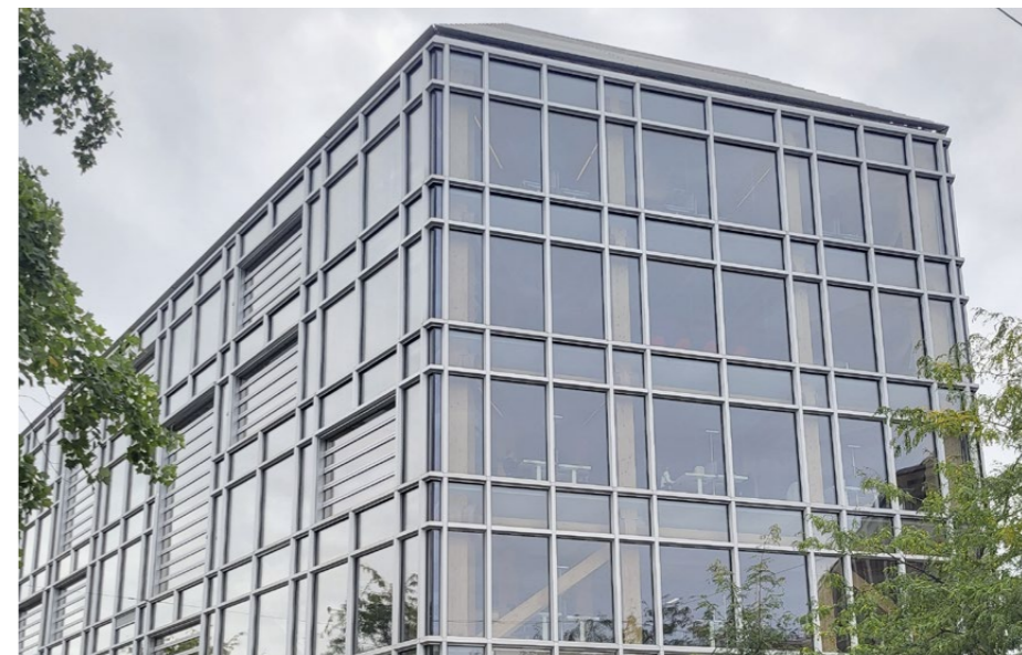
Das Hauptgebäude der heutigen TX-Gruppe, ehemals Tamedia, war Shigeru Bans erstes grosses Schweizer Bauprojekt.
