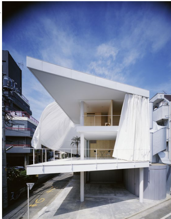
Viel mit Textilien arbeitete Ban beim «Curtain Wall House», das er 1995 in der Tokioter Präfektur Itabashi realisierte.
