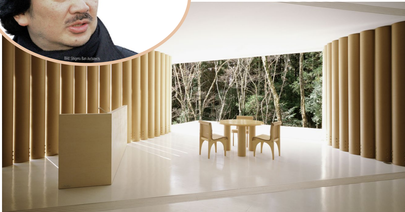
Kartonröhren als konstruktive Elemente: Das 1995 gebaute «Paper House» am Yamanaka-See, Präfektur Yamanashi, Japan.
