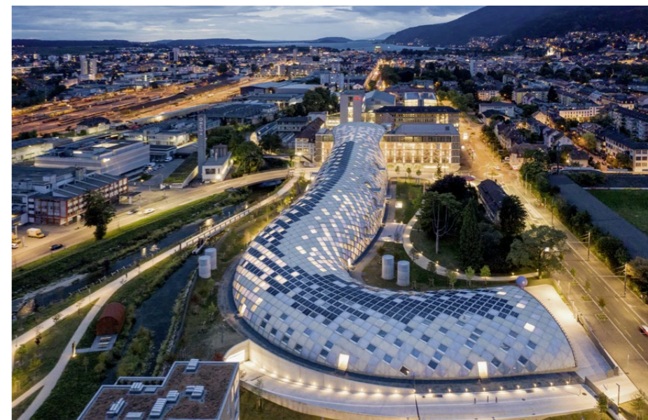
Das Hauptgebäude des Swatch/Omega Campus in Biel, eine 237 Meter lange Konstruktion aus Leimholzsäulen und Brettsperrholz.
