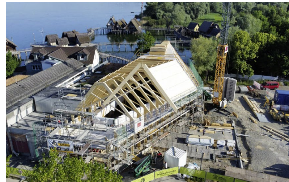
Dank der Vorfertigung der Bauteile konnte das Dach in nur vier Wochen errichtet werden.
