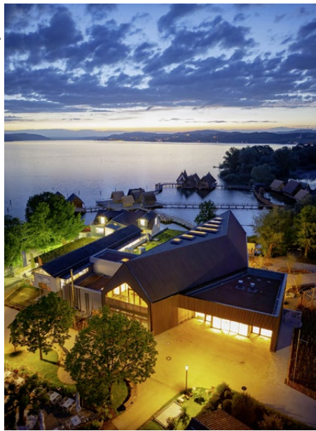
Ganz rechts ist das neue Besucherfoyer zu sehen. In der Mitte der neue Museumsbau, an den sich links die Bestandsbauten anlehnen.
