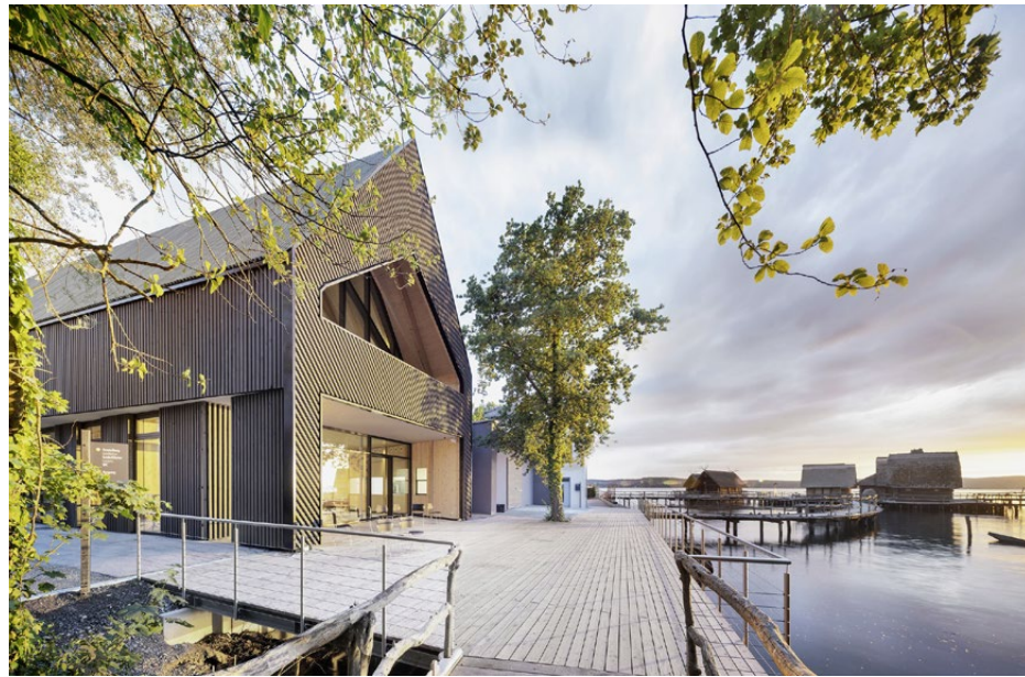
Der neue Museumsbau fügt sich mit seiner Holzbauweise harmonisch in die Architektur der Pfahlbauten im Freilichtbereich ein.
