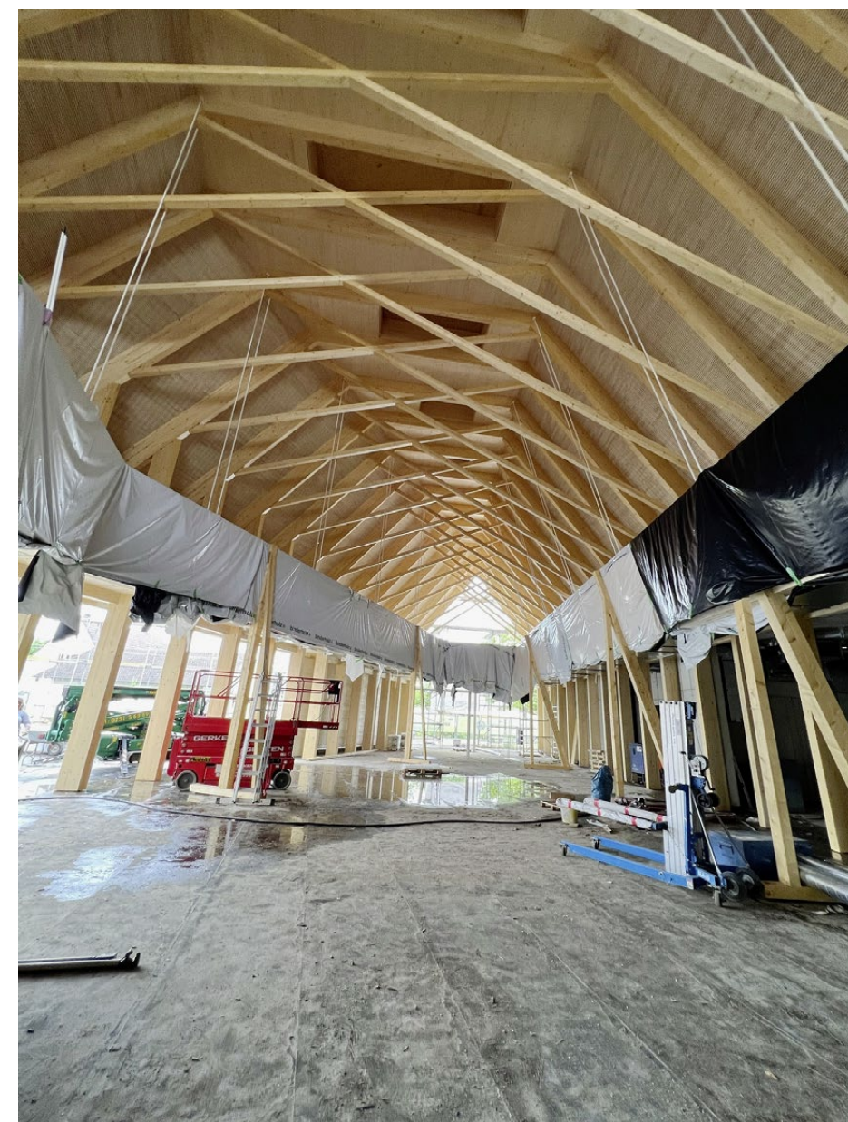
Von der über 12 Meter hohen Dachkonstruktion wurde mittels Zugstangen aus Stahl die hier noch eingepackte Galerie abgehängt.
