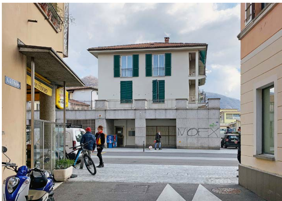
Auf der ehemals stark befahrenen Via San Gottardo in Balerna TI wurde Platz geschaffen für den Fuss- und Veloverkehr sowie für Begegnungsorte, doch fehlen Grünbereiche.
