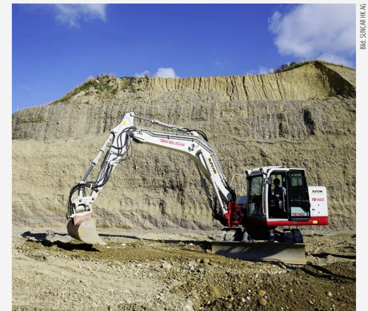
Grössere Kiste: der mit Strom betriebene «Takeuchi TB1140», immerhin 16 Tonnen schwer.
