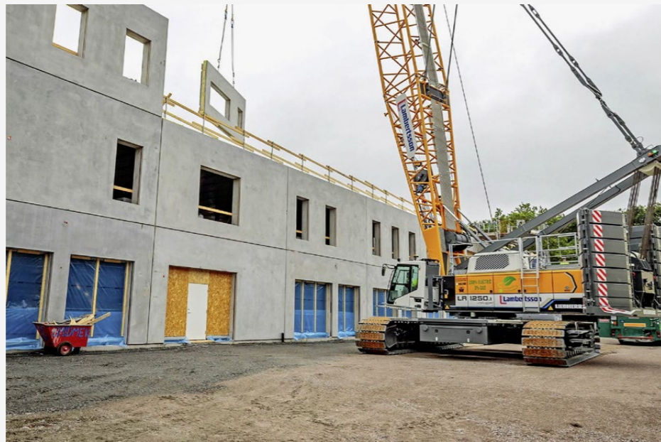
Der erste elektrifizierte Raupenkran der Welt, der «LR1250.1 unplugged», ist stolze 212 Tonnen schwer und verfügt über eine Hebeleistung von 250 Tonnen.
