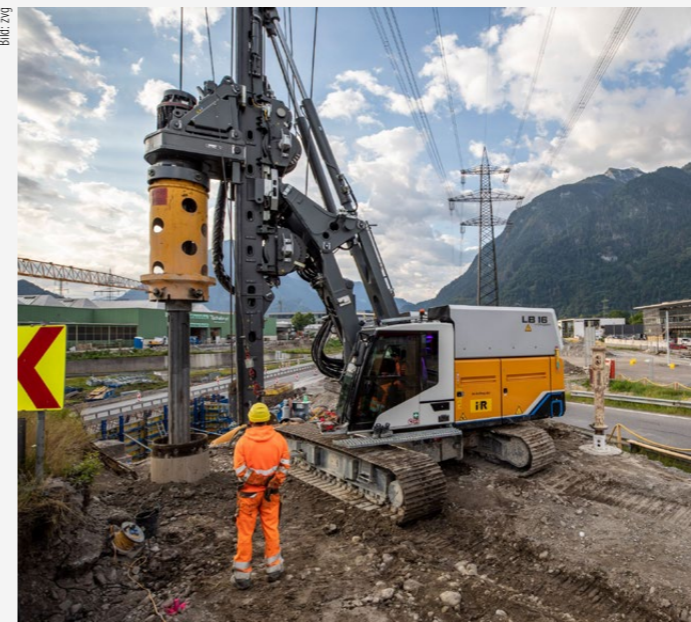
Zusammenarbeit mit Liebherr: das 55-Tonnen-Drehbohrgerät «LB16». Es kann mit einer vollen Batterieladung rund zehn Stunden arbeiten.
