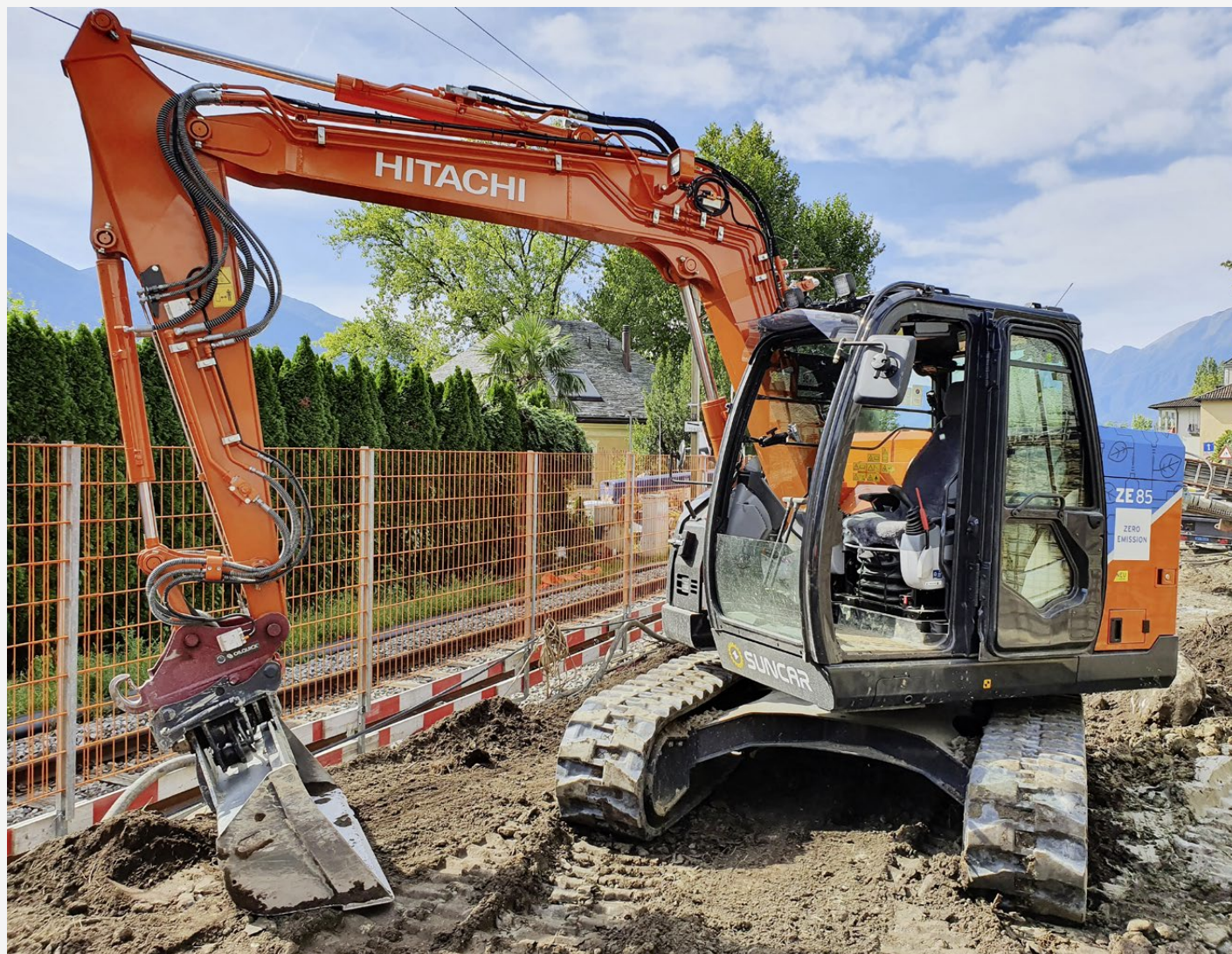
Der elektrisch betriebene «Hitachi ZE85», von Suncar entwickelt, wurde auf der SBB-Baustelle in Minusio TI während eines Jahres mit Erfolg getestet.
