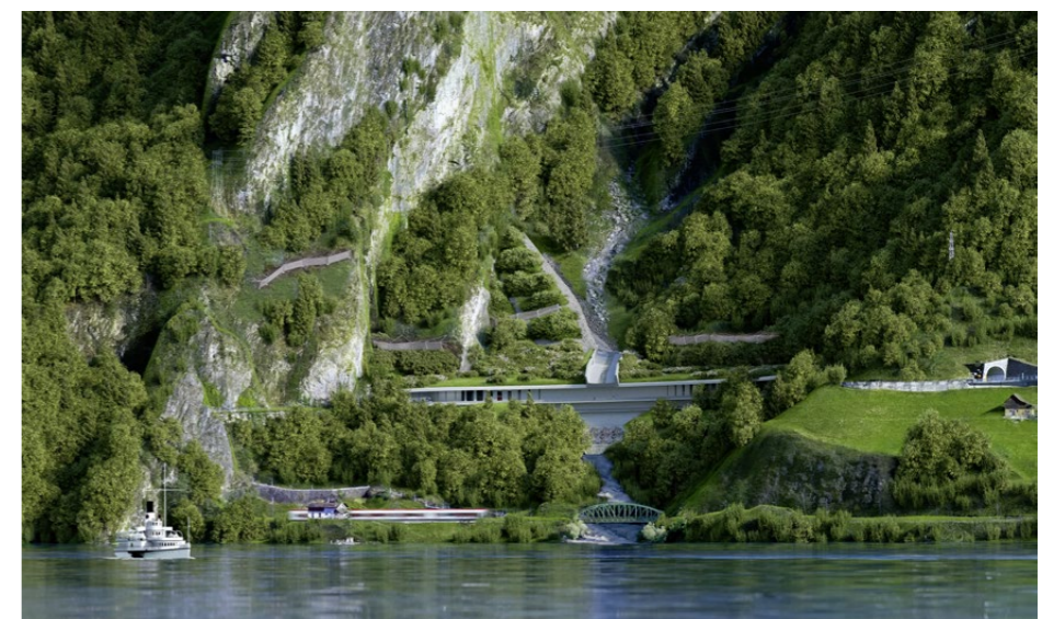
Visualisierung einer der Vorarbeiten an der neuen Axenstrassen: Diese Galerie wird dereinst den Anschluss Gumpisch zum Sisikoner Tunnel vor Steinschlag schützen.
