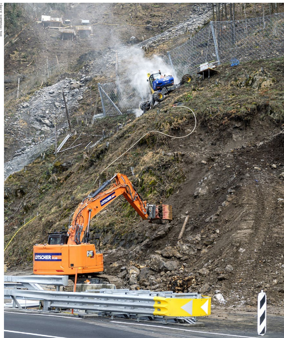
Die umfangreichen Vorarbeiten für die beiden Tunnel der neuen Axenstrasse A4 laufen unter schwierigen Bedingungen. 700 Millionen Franken sind dafür budgetiert.
