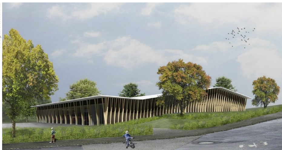
Auch den Luzerner Gemeinden geht es gut. So hat Beromünster kürzlich knapp 21 Millionen Franken für diese neue Dreifach-Turnhalle bewilligt.
