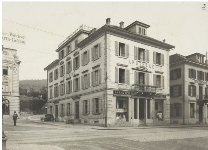
Das fast 200 Jahre alte Gebäude an der Neugasse 1 am Eingang zur Zuger Altstadt wird saniert und umgebaut.
