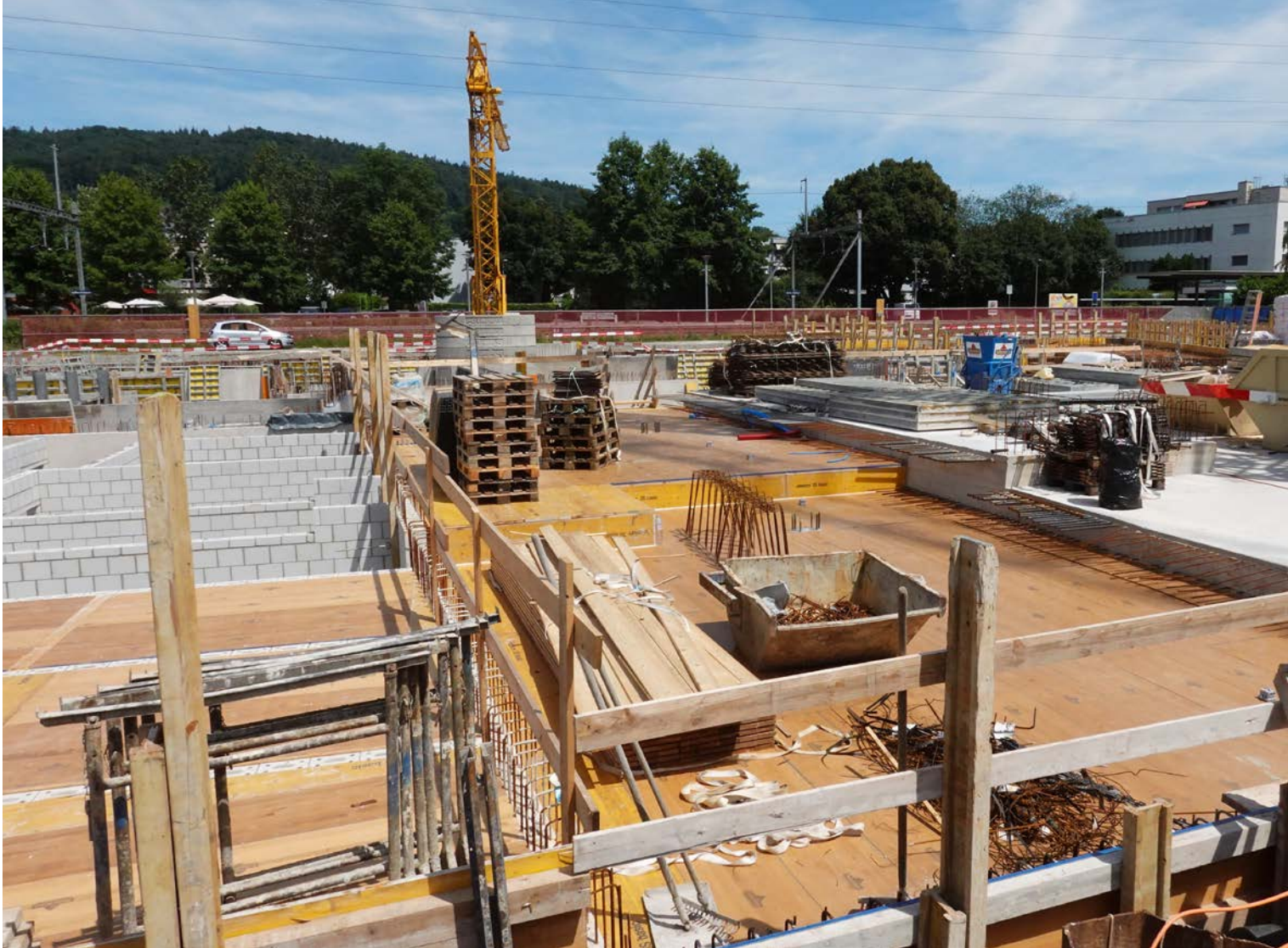
In der Agglomeration von Zürich schiessen zurzeit die Mehrfamilienhäuser nur so aus dem Boden (im Bild: das Projekt «Müliwisen» hinter dem Bahnhof Buchs-Dällikon).
