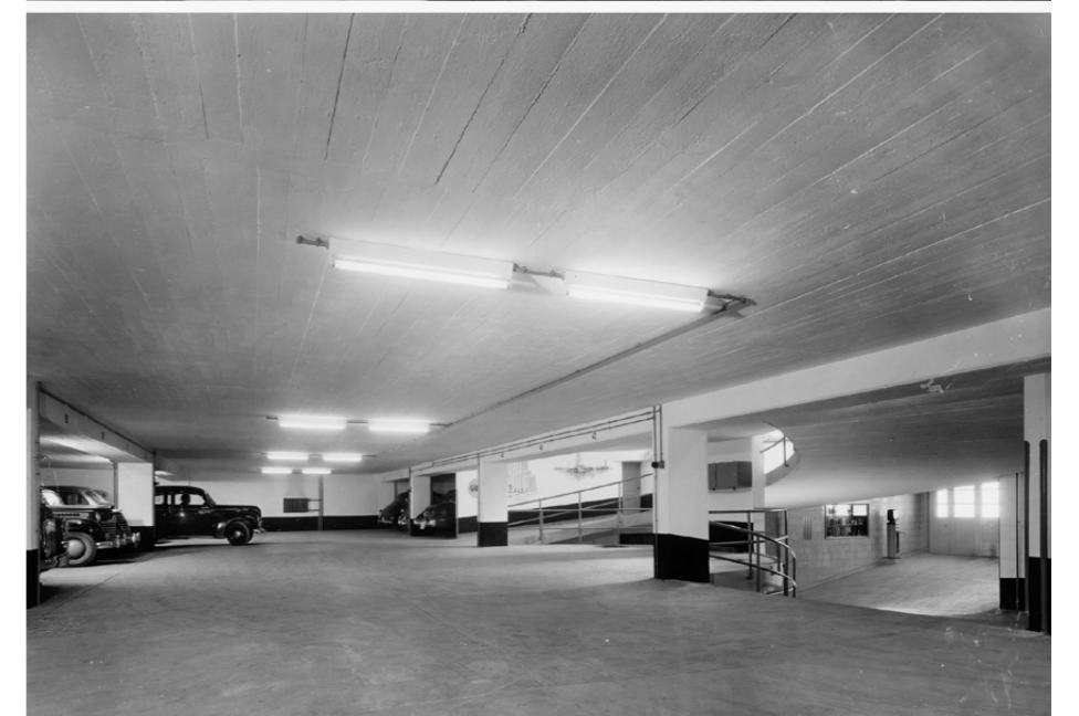
Die Aufnahmen der Parkgarage bei der Einmündung der Huttenstrasse in die Schmelzbergstrasse stammen aus dem Jahr 1951. Die weissen Wände der Halle waren mit blauen Wandmalereien geschmückt.
