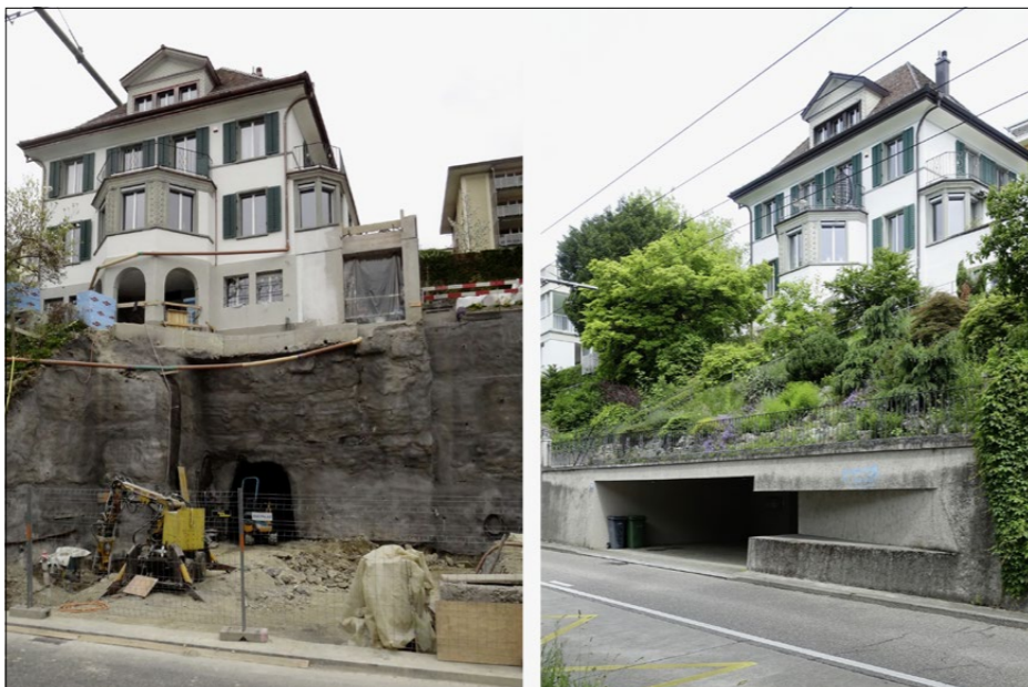
Die beiden Fotos aus den Jahren 2014 und 2024 zeigen, wie an der Ottenbergstrasse in Zürich-Höngg eine neue Kaverne in den Hang eingefügt wurde. Sie hat offenbar einen «Hinterausgang».
