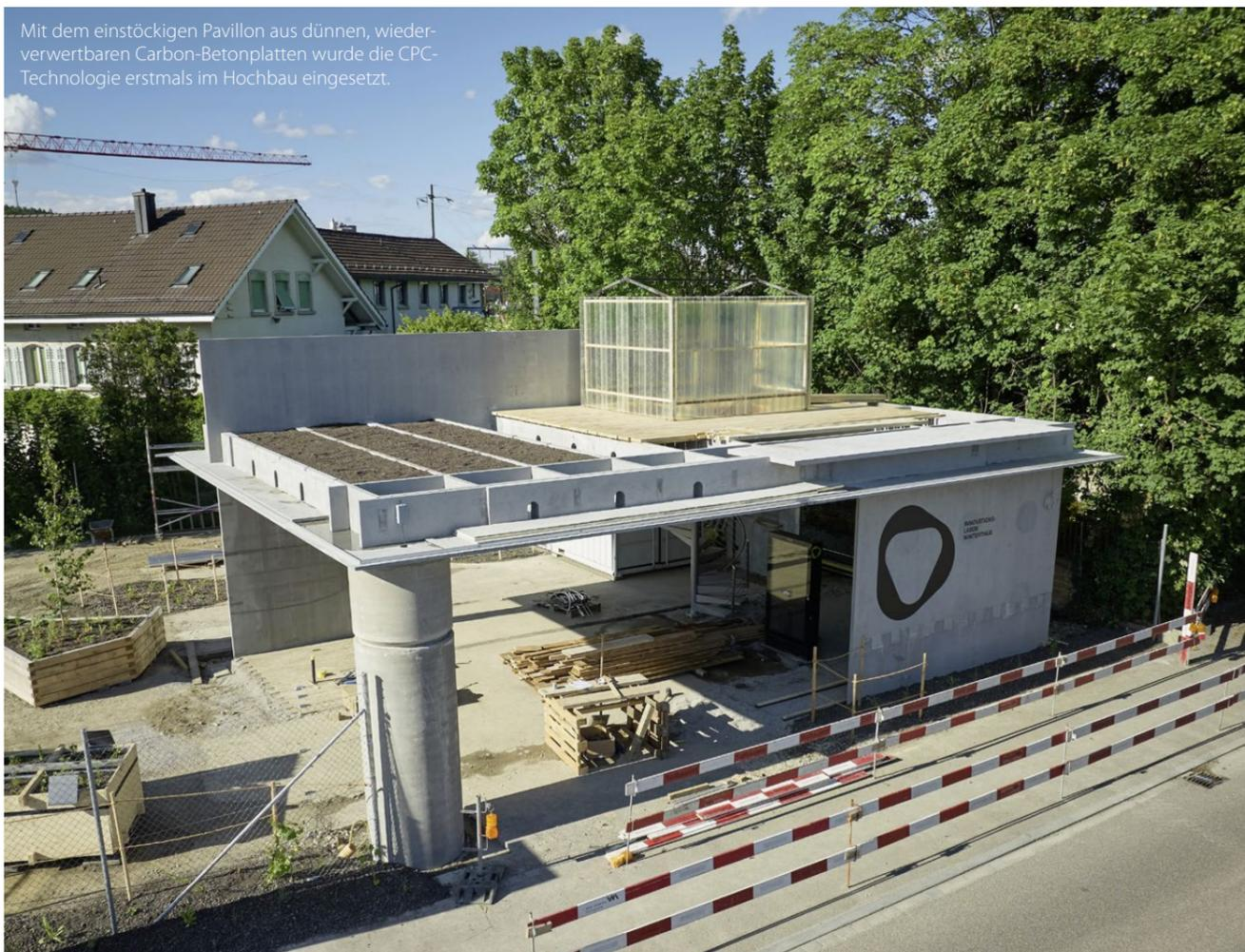
Mit dem einstöckigen Pavillon aus dünnen, wiederverwertbaren Carbon-Betonplatten wurde die CPC-Technologie erstmals im Hochbau eingesetzt.
