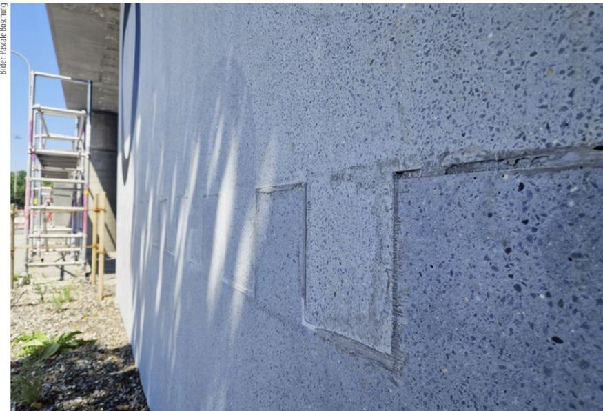
Die Plattenverbindungen sind für das flexible CPC-Bausystem zentral und funktionieren ähnlich den Passverbindungen im traditionellen Holzbau, wie er zum Beispiel in Japan angewandt wird.
