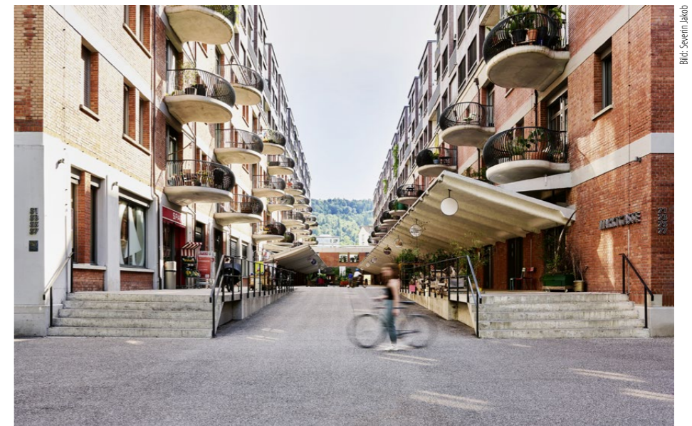
Blick in die Marktgasse: Umbau und Aufstockung von Marcel Meili und Markus Peter Architekten.
