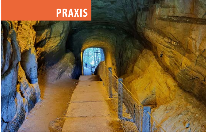
Das teledynamische Kabel wurde durch einen eigens gehauenen Stollen geführt, der heute nur noch einen Wanderweg beherbergt.
