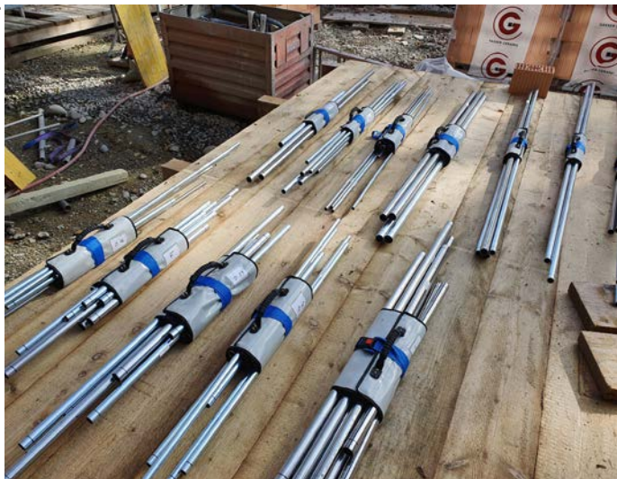
Alles nach Mass: Bei der Müller Wüst AG werden die Rohre zugeschnitten und raumfertig konfektioniert.
