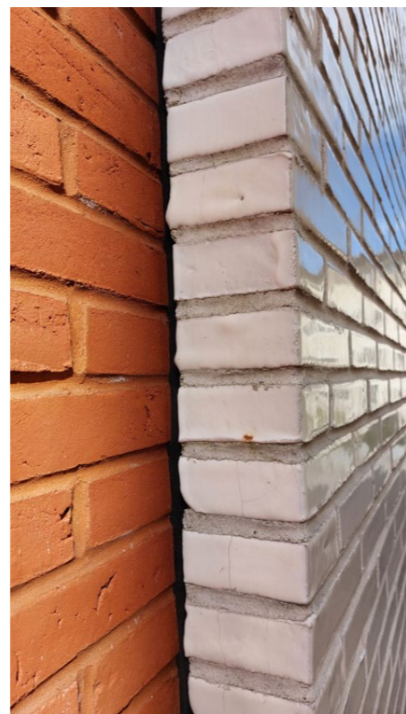
Verwendet wurden halb manuell, halb industriell gefertigte Backsteine, die an der Hauptfassade weiss glasiert wurden. Auf diese Weise ergibt sich ein moderner Touch.
