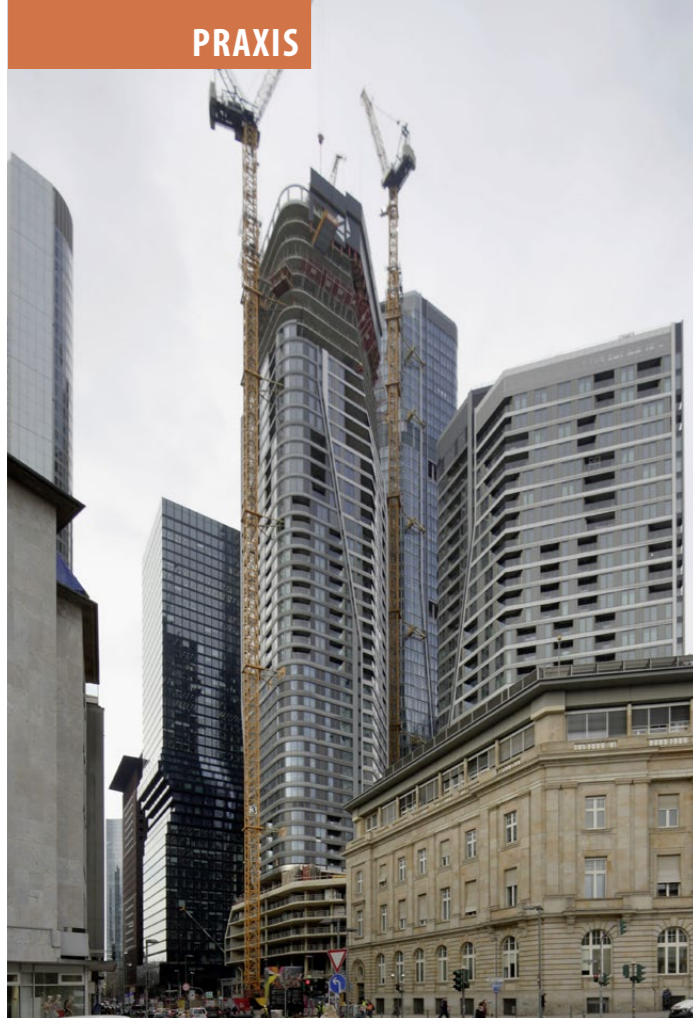
Das «Frankfurt Four»-Ensemble vom nahen Frankfurter Rossmarkt aus gesehen. Links und rechts an den hohen Türmen sind die aussen liegenden Baustellenaufzüge zu sehen.
