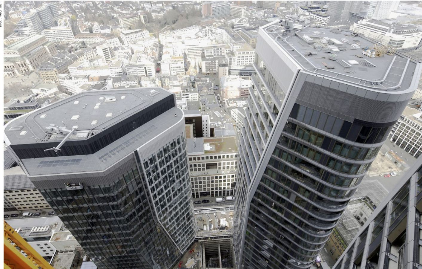
Blick von der Ablageplattform auf die kleineren Türme. Der Niedrigste ist bereits fertiggestellt. Der zweitniedrigste Turm ist zum Wohnen gedacht.
