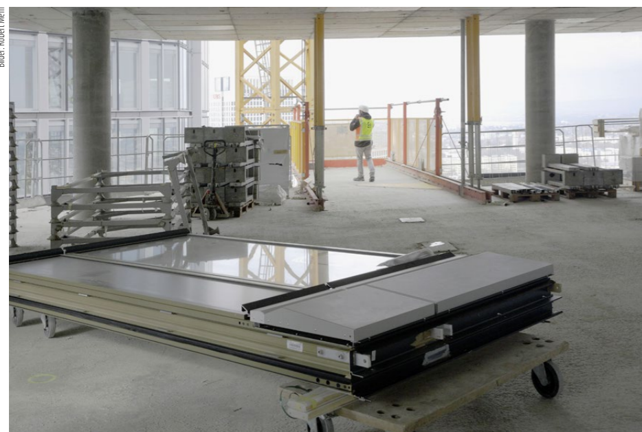
Auf diesem Geschoss in einem der Wohnbauten werden gerade Fassaden montiert. Im Vordergrund ein Fassadenelement, im Hintergrund die temporäre Ablageplattform für den Hochkran.
