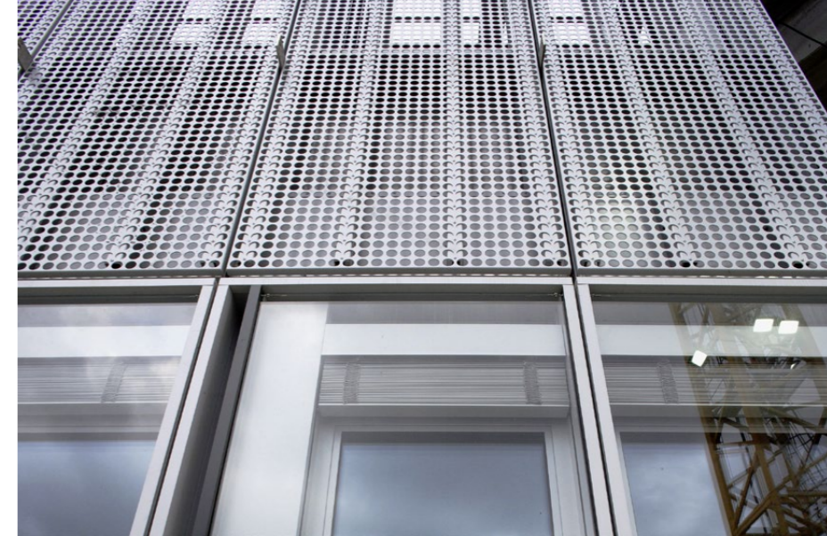
Aus der Nähe betrachtet handelt es sich bei den geschlossenen Fassadenelementen der Technikgeschosse um Lochbleche.
