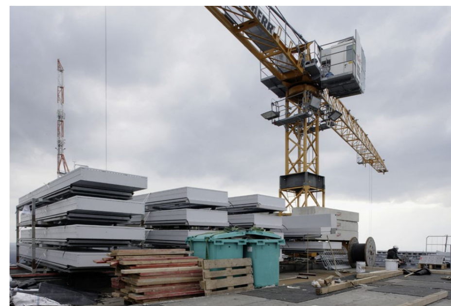
Auf dem Dach des über 200 Meter hohen Bürotowers werden die zur Montage vorbereiteten Fassadenelemente zwischengelagert.
