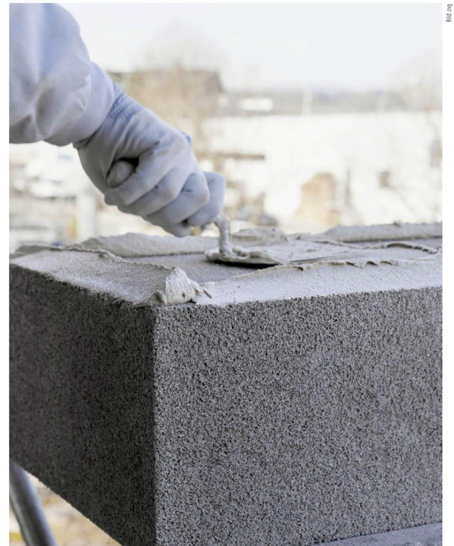
Der Dämmschaum «SwissporEcorit» ist leicht, einfach zu verbauen und besteht aus Bauschutt. Zudem kann er nach dem Rückbau immer wieder zu neuen Dämmplatten verarbeitet werden.
