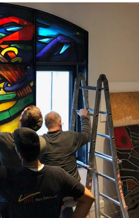
Einbau der Design-Fenster für das Hotel
