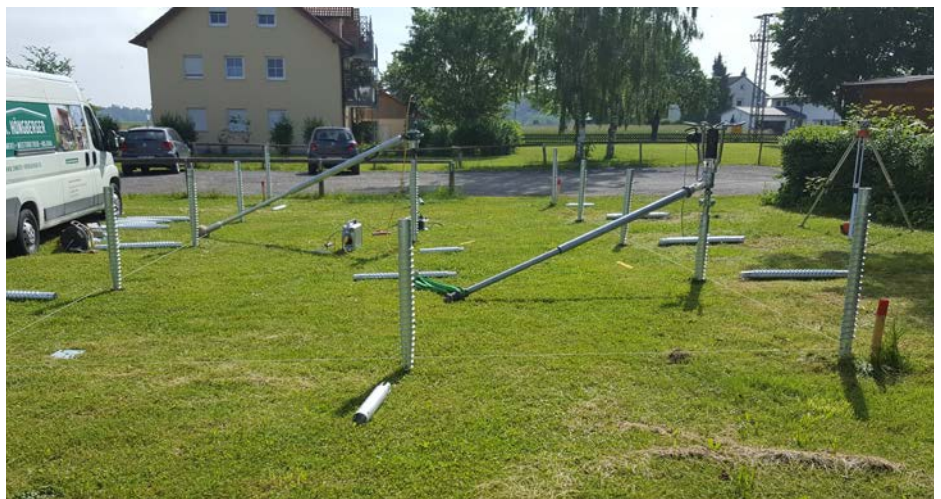
Absteckmaterial, Schraubfundamente, Eindrehmaschine und Strom – mehr braucht es nicht, um einen belastbaren Untergrund für Objekte im Garten zu schaffen.
