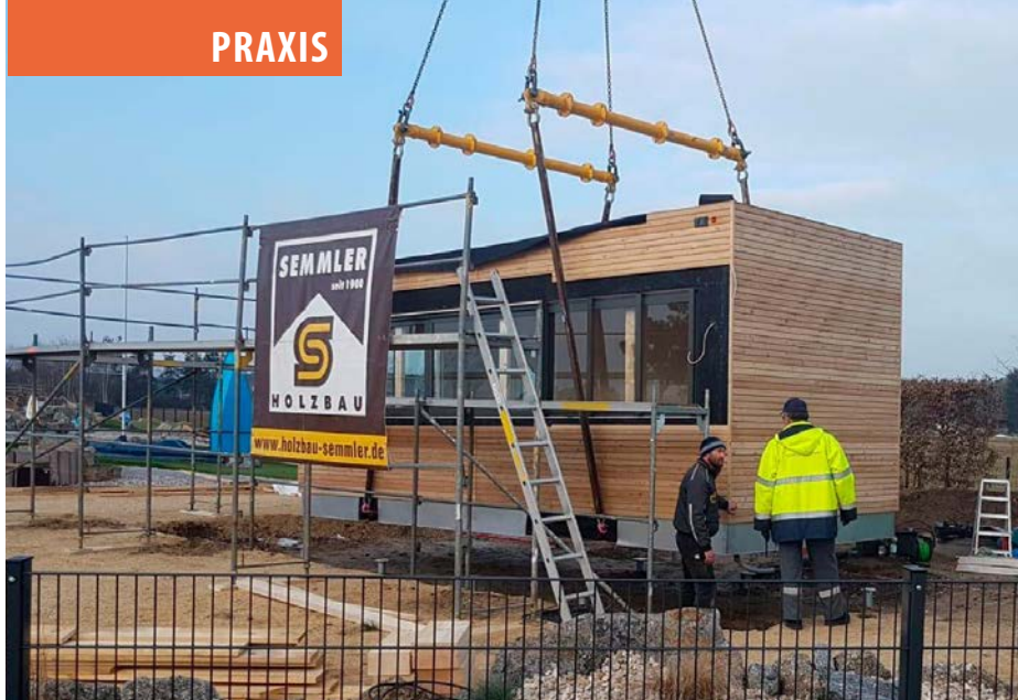
Moderne Wohnarchitektur kommt mit geringster Bodenbewegung aus. Dieses kellerlose Tiny House wird in Rekordzeit auf Schraub-Pfahl-Fundamenten aufgestellt.
