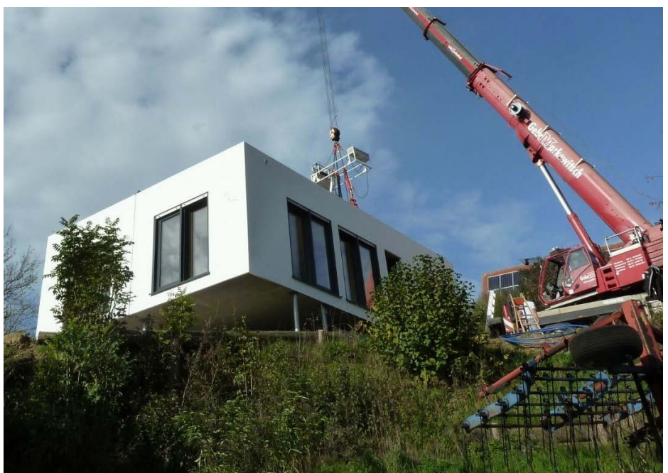
Ohne nennenswerten Aufwand gelingt beim Errichten von Gebäuden in Hanglage der zwingend notwendige Hangausgleich – durch Fundamente aus Stahl.
