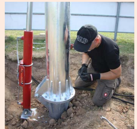
«Steelroot» in der Fundamentgrube platzieren, Mast aufrichten und beides miteinander verschrauben – so entstehen schnell solide Ergebnisse.
