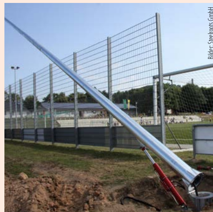
«Steelroot» in der Fundamentgrube platzieren, Mast aufrichten und beides miteinander verschrauben – so entstehen schnell solide Ergebnisse.
