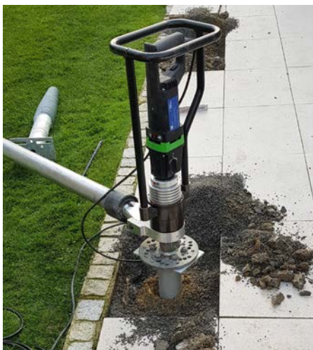
Absteckmaterial, Schraubfundamente, Eindrehmaschine und Strom – mehr braucht es nicht, um einen belastbaren Untergrund für Objekte im Garten zu schaffen.
