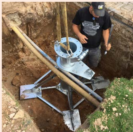
«Steelroot» in der Fundamentgrube platzieren, Mast aufrichten und beides miteinander verschrauben – so entstehen schnell solide Ergebnisse.
