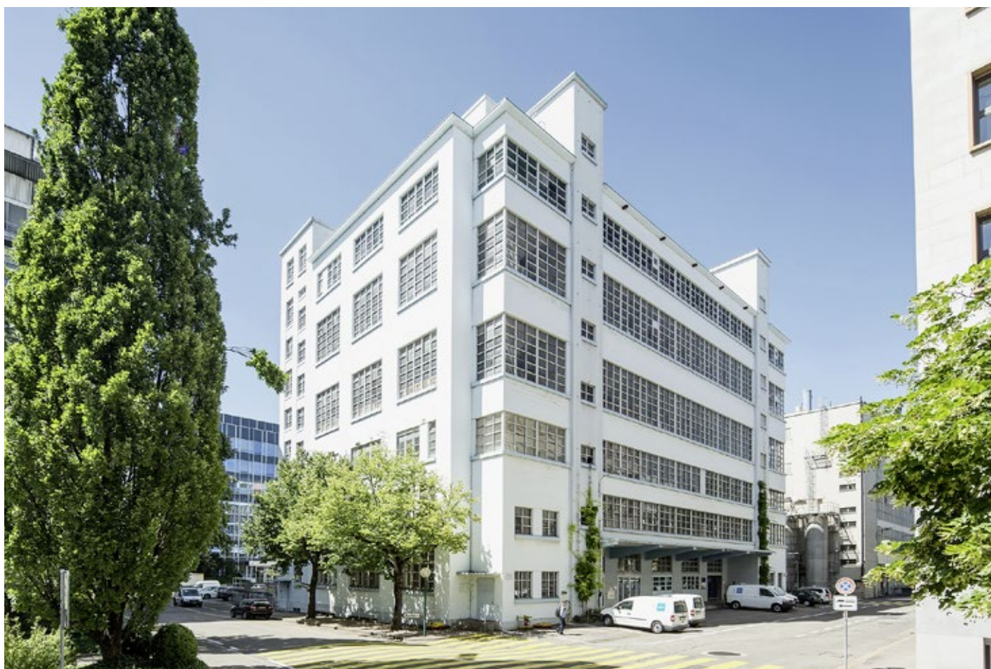
Der Bau an der Klybeckstrasse 141 diente ursprünglich als Magazingebäude. Er ist gänzlich aus armiertem Beton errichtet. Das Bauwerk wird im Inventar der schützenswerten Gebäude aufgeführt, unter anderem wegen seiner grossflächigen Fensterbänder mit feiner Metall-Sprossierung.
