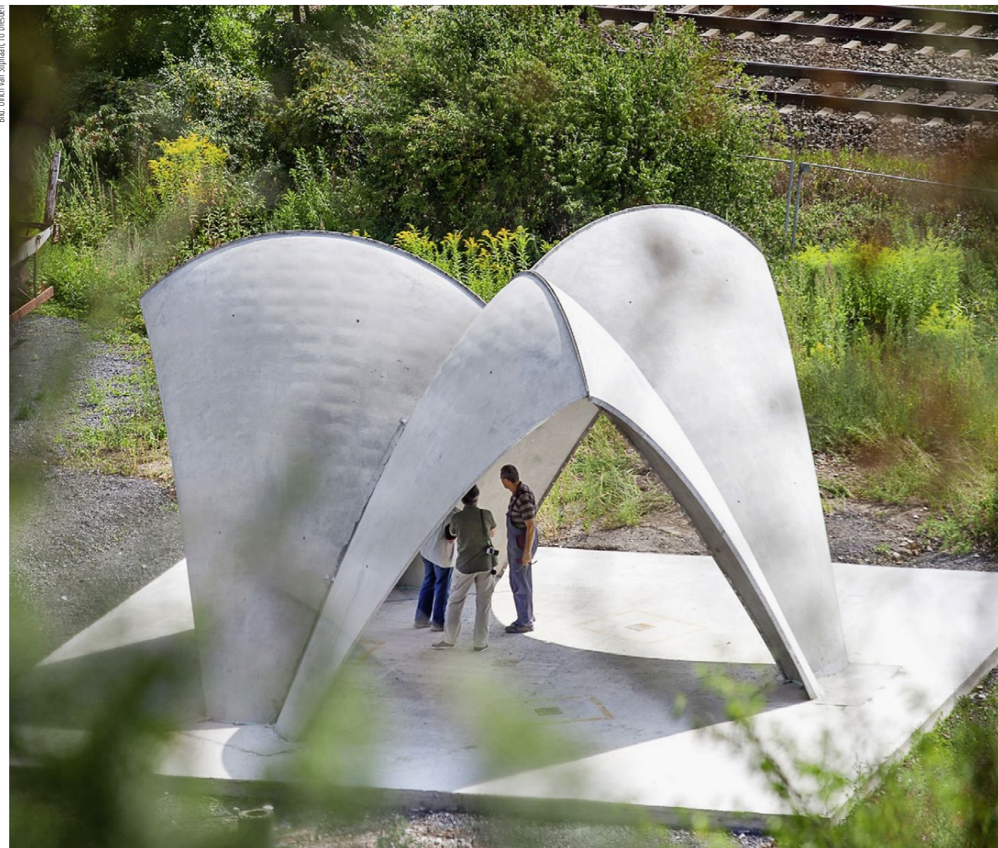
Ein Pavillon aus Carbonbeton in Thüringen. Der Baustoff ermöglicht eine filigrane Architektur.
