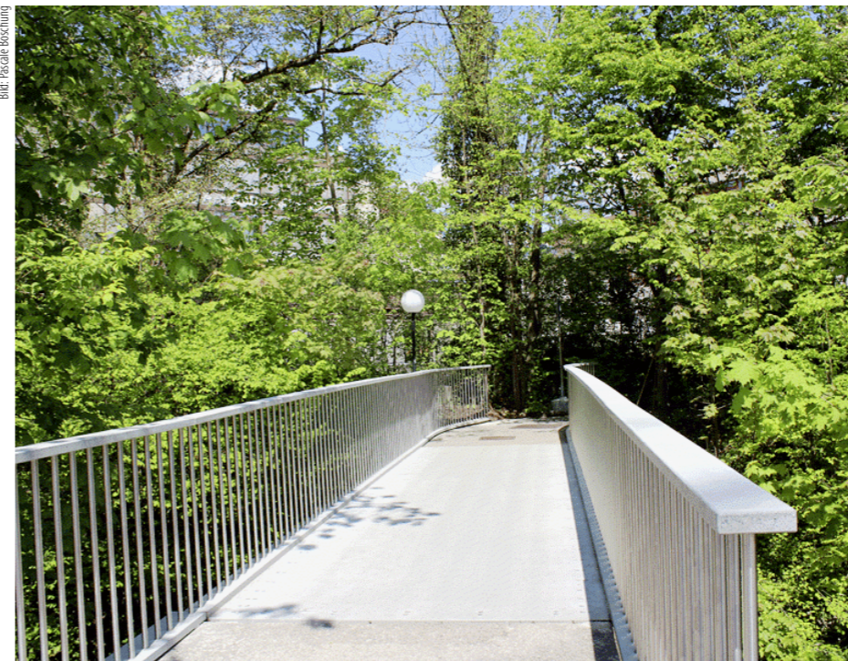
Die «leichteste Betonbrücke» der Welt in Winterthur.
