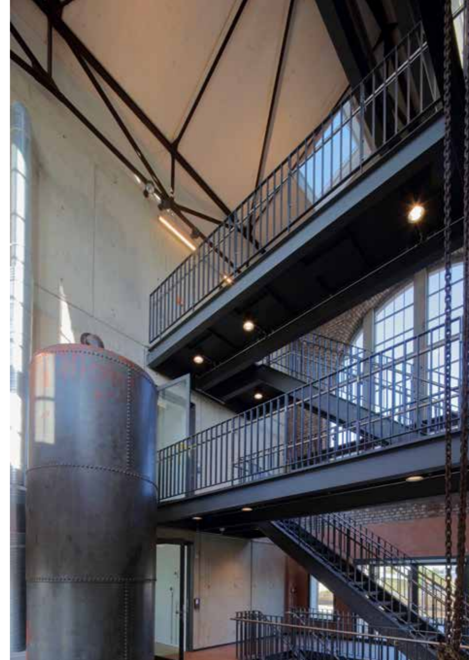
Das neue zentrale Treppenhaus mit durchgehenden Stahlträgern.
