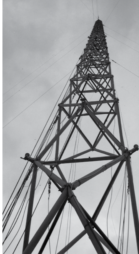
Der 125 Meter hohe Funkmast auf dem Kasernenareal in Kloten steht zu nahe beim Anflug zur Westpiste 28. Deshalb muss er 1947 für den Bau des neuen Flughafens abgebrochen werden.
