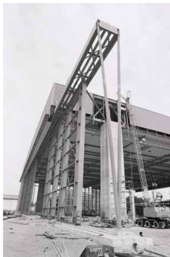
Bauarbeiten an der Werft II des Flughafens. Wie diese Aufnahme von 1973 zeigt, war damals ein Seilzug-Bagger im Einsatz
