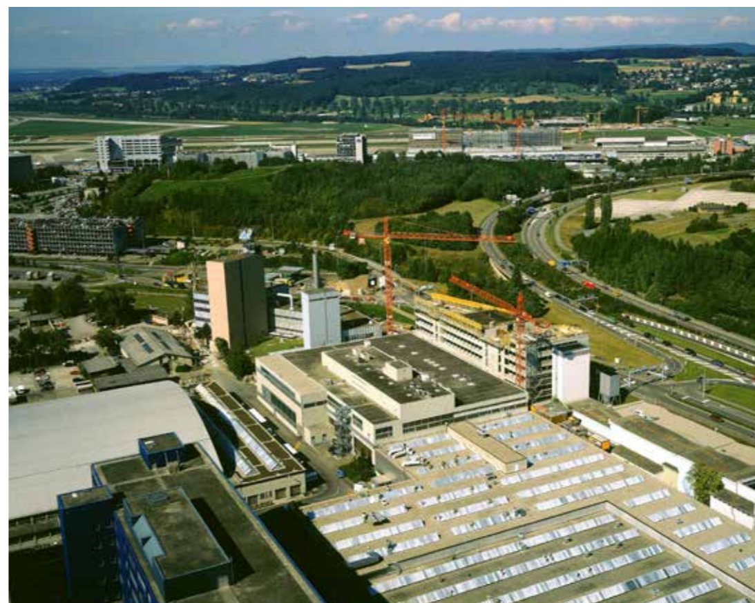
Im Herbst 1996 sind die Bauarbeiten an einem weiteren Werftgebäude weitgehend abgeschlossen.
