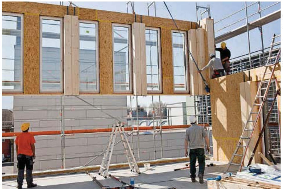
Die vorgefertigten Elemente werden montiert.
