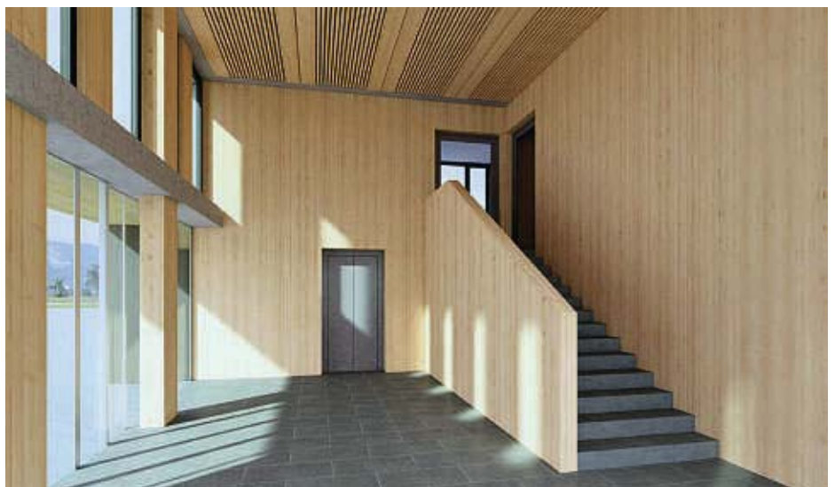
Das Holz ist im Innern sichtbar, es gibt keine Verkleidungen.
