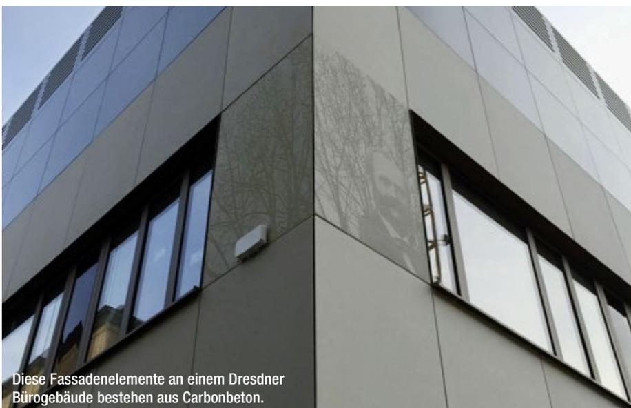
Diese Fassadenelemente an einem Dresdner Bürogebäude bestehen aus Carbonbeton.
